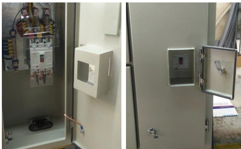
شکل ۲: دریچه قطع و وصل کلید اتوماتیک
