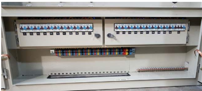
شکل ۴: روبند کلید فیوزهای مینیاتوری خروجی
