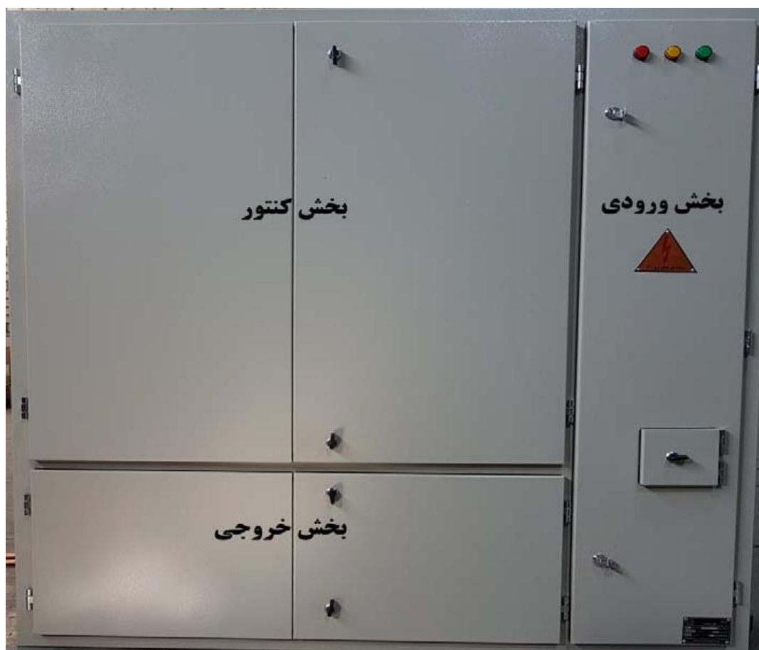
شکل ۱: بخش‌های مختلف تابلوی لوازم اندازه‌گیری آپارتمانی
